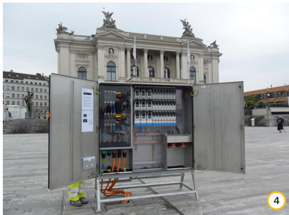
GIFA 800A Verteilschrank robust in rostfreier Ausführung. Steckbare Einspeisungen 2x400A auf PowerSafe Panelbox. Direktabgänge über NH und steckbare CEE 125 + 63A
